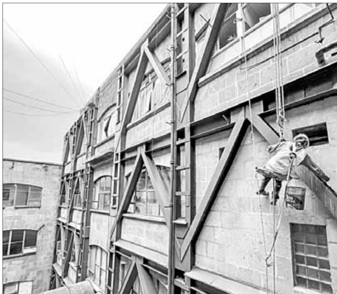
▲ Un trabajador realiza labores de pintura en la estructura metálica que refuerza el edificio de
