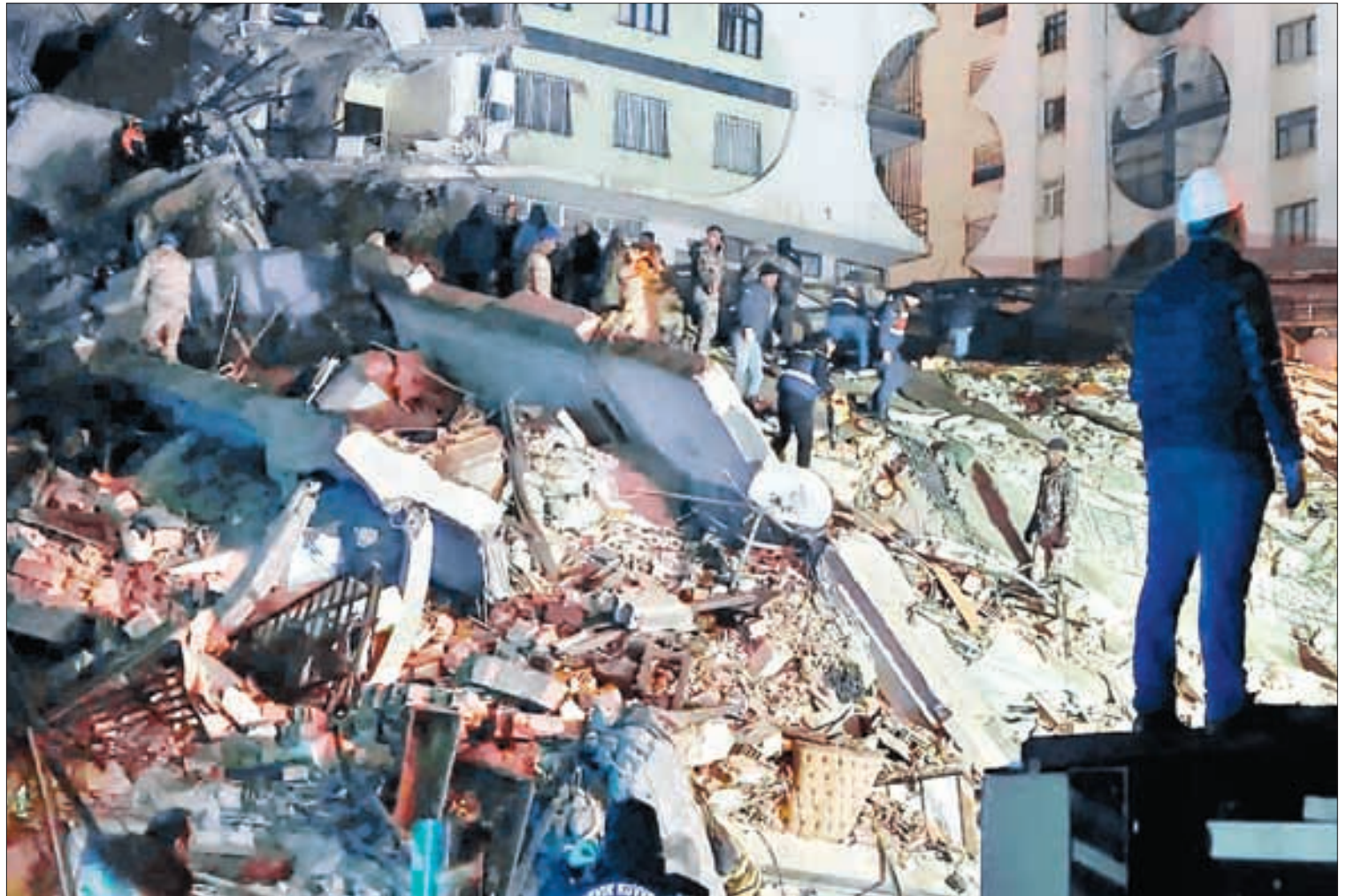
▲ Un terremoto de magnitud 7.9 causó el derrumbe de decenas de edificios en los dos países. En las provincias turcas de Osmaniye, Kahranmanmaras y Diyarbakir (imagen) reportan 76 fallecimientos.
